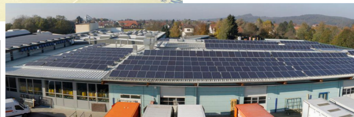
Photovoltaik-Anlage Katzbeck, eine der größten PV-Anlagen im Burgenland auf dem Dach eines Industrieunternehmens: ERHART-EMS lieferten die PV-Standortentwicklung, Beschaffung und Umsetzungsbegleitung.
